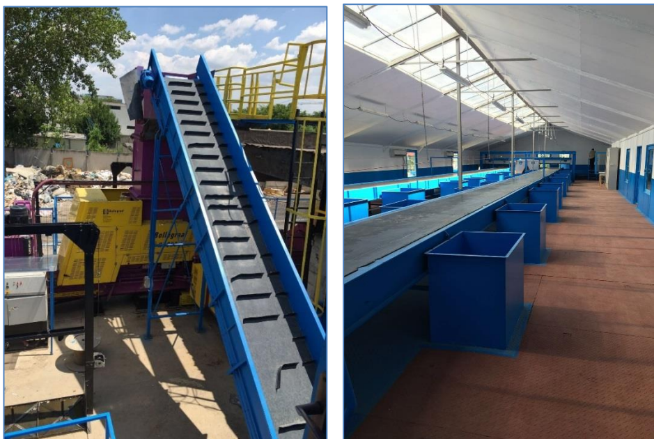
Figura 4-17: Stație de sortare S.C. URBAN S.A.
