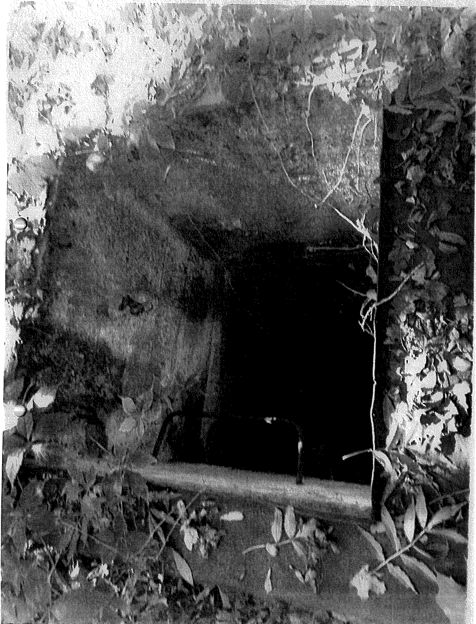
INTRARE TUNEL PALAT FABRICA DE CONCRETE
